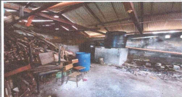
Foto 2: Así esta la de adentro de la cocina actualmente.
